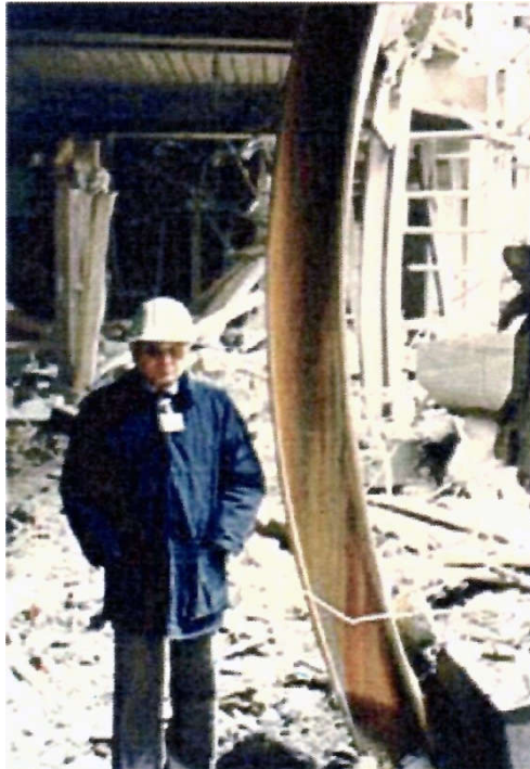
Рис. 10. Деформація колони від впливу вибухової хвилі
